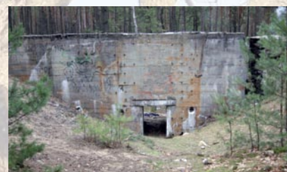
Regelbau 514 na Pohulance – ściana tylna z wyjściem ewakuacyjnym
