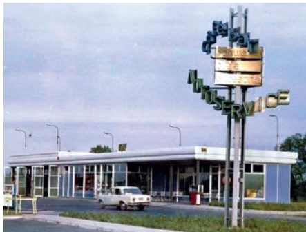
Budynek stacji AGIP. Lata 1970-te (stacja Sosiba)
