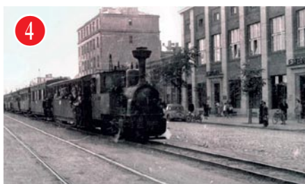
Ciuchcia przy Zakładach E. Wedla na Zamoyskiego. Nieopodal mieściła się stacja „Rogatki Grochowskie” przy skrzyżowaniu z ulicą Lubelską. Stojące do dziś budynki tylko nieco przesunięte wobec pierwotnej lokalizacji zostały oddane do użytku wraz z budową bitej Szosy Brzeskiej w roku 1825, w miejscu posterunku w linii Okopów Lubomirskiego z 1770 roku. Lata 30-te.
