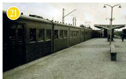
21 Peron stacji Wesola ze „skrzydlatym” zadaszeniem. Z prawej strony w głębi zarys starego, drewnianego dworca. Lata okupacji.
