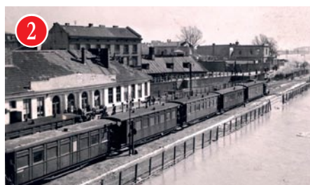
Stacja Warszawa – Most. Widać wyraźnie, jak poziom Wistoty był blisko torów kolejowych. Przez swoje położenie dość często były zalewane. Za widocznymi zabudowaniami, przed Portem Praskim, ciuchcia skręcała w lewo, w stronę ulicy Zamoyskiego. Lata 30-te. (Fotopolska)
