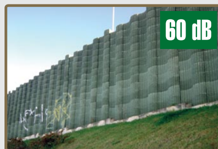
Fot. 4. Trasa Siekierkowska na nasypie, ogrodzona murem – 60 dB (fot. D. Wrońska)
