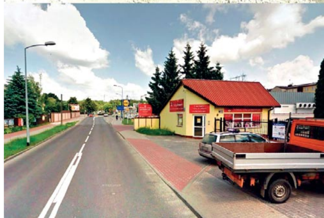
ULICA TORFOWA podczas budowy jezdni asfaltowej pomiędzy kanałkiem, a Gościńcem w 2003 roku. Zaraz po tym na odcinku od Traktu do dzisiejszego ronda „Macierowe Bagno” zmieniono jej nazwę na Jana Pawła II.
